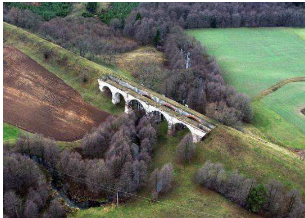
Wiadukty w Kiepojciach
